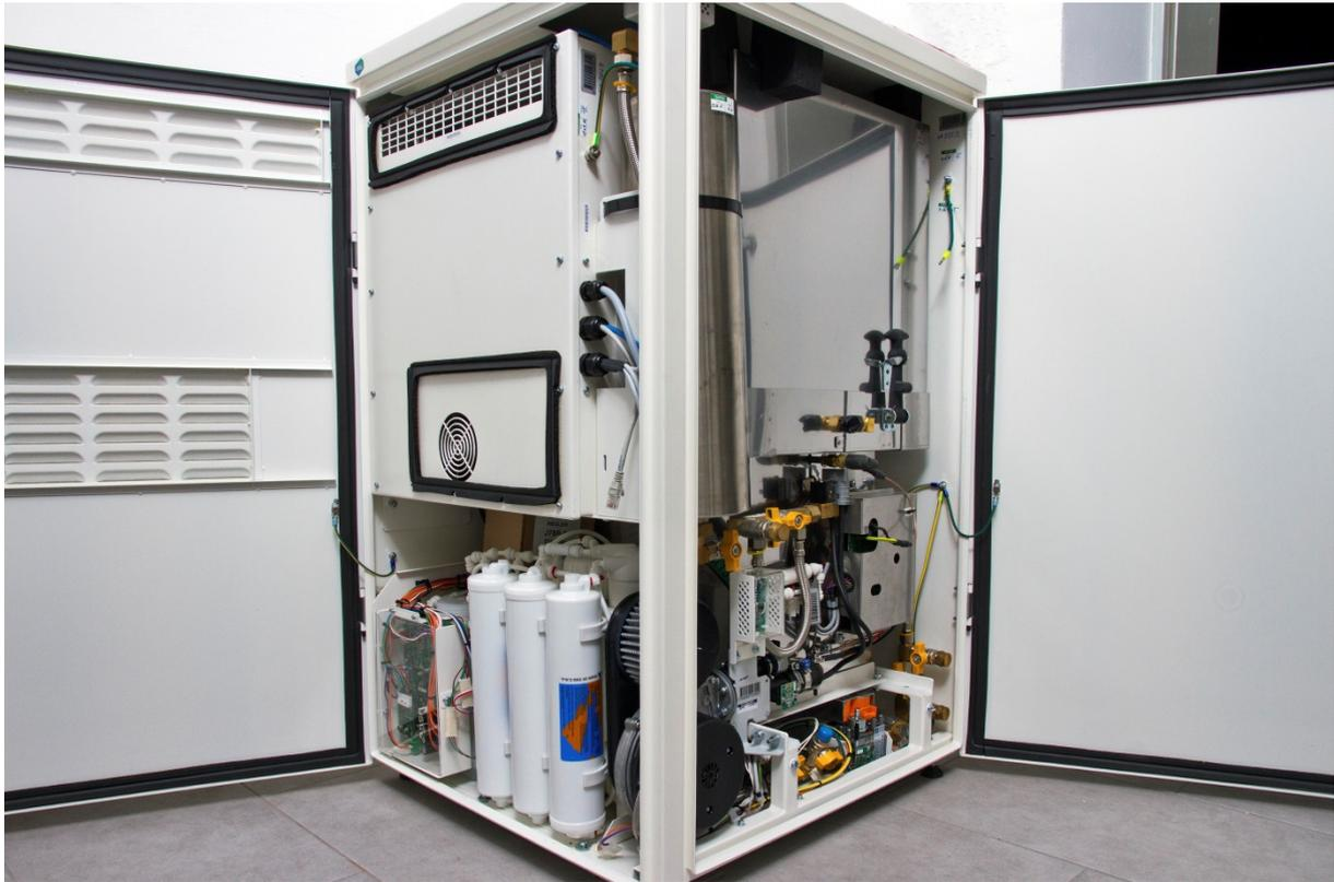
*Zukunftstechnologie Brennstoffzelle „BlueGen“, die Wasserstoff aus Gas in elektrischen Strom und Wärme umwandelt*
